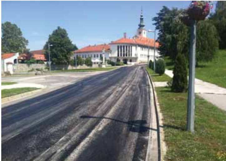
Novoasfaltirana Ulica hrvatskih pavlina
