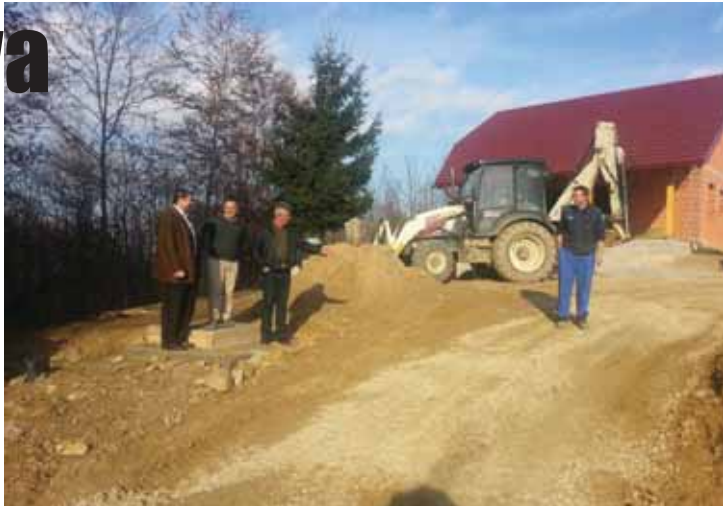
Počeli i radovi na vodovodu Zlogonje - Hadijaki
