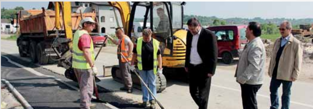
Stavljanjem završnog tepiha asfaltnog sloja kraju je privedena izgradnja nogostupa Vulišinec – Kamenički Vrhovec
