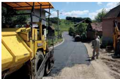
Završeni su i radovi u naselju Antekolovići
