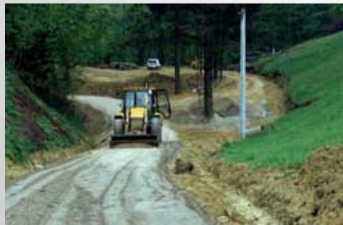
Radovi na rekonstrukciji spojne ceste završeni su u svibnju
