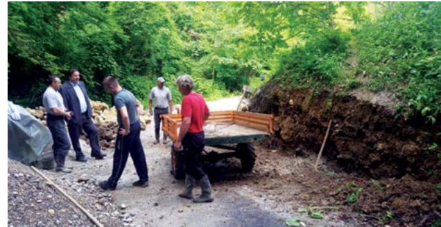
Škarpa se gradi "zajedničkim snagama" Grada i građana
