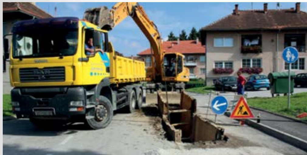
Tijekom ljeta trajali su intenzivni radovi na novoj kanalizacijskoj mreži u središtu Lepoglave
