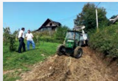
Saniraju se oštećenja na lokalnim putevima
