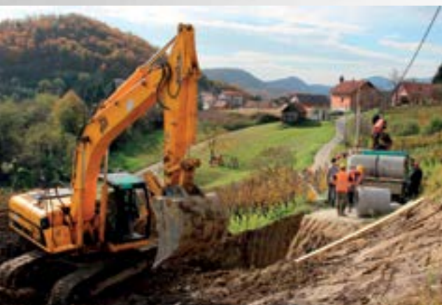
Za sanaciju terena korištena je teška građevinska mehanizacija
