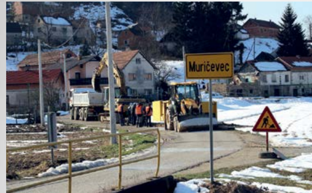
Gradnja kanalizacijskog sustava nastavljena je u Muričevcu
