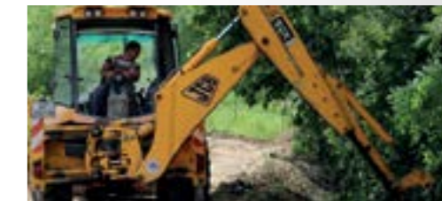
Na lepoglavskom području u tijeku su radovi na uređenju nerazvrstanih cesta
