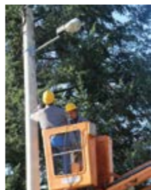
Postavljanje rasvjetnih tijela
