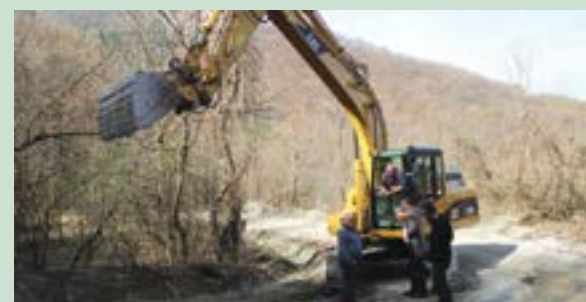
U tijeku su radovi na uređenju šumskih prometnica na području Grada Lepoglave
