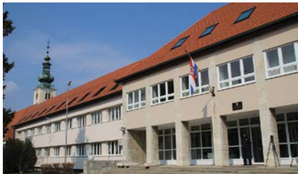
Zahvaljujući projektu energetske obnove osigurani su i bolji uvjeti rada za zaposlene te poboljšani uvjeti života zatvorenika u kaznionici
