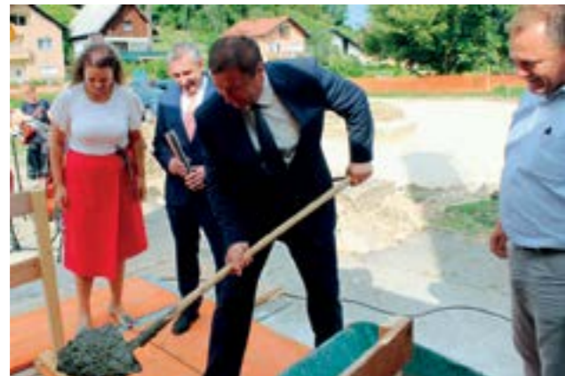
Polaganjem povelje u temelje zgrade Dječjeg vrtića i službeno su započeli radovi na njejoj rekonstrukciji
