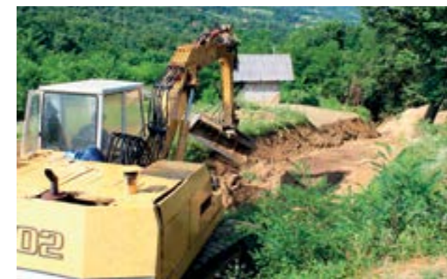
Radovi na uređenju komunalne infrastrukture odvijaju se i na području Mjesnog odbora Lepoglavska Ves
