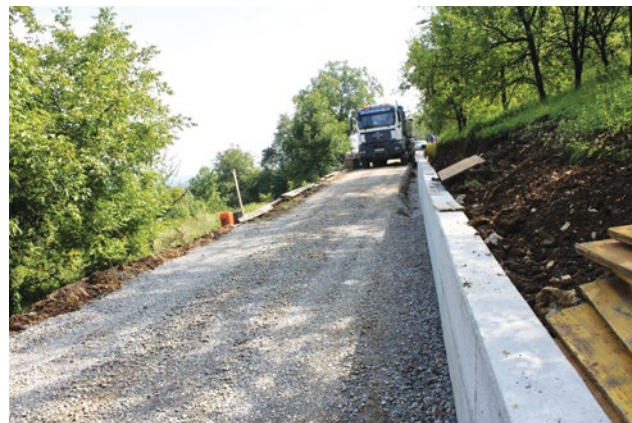
U Mjesnom odboru Lepoglava u tijeku su radovi na sanaciji klizišta
