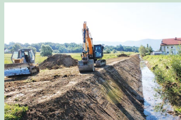
U tijeku su radovi na uređenju korita vodotoka u Žarovnici i Kamenici
