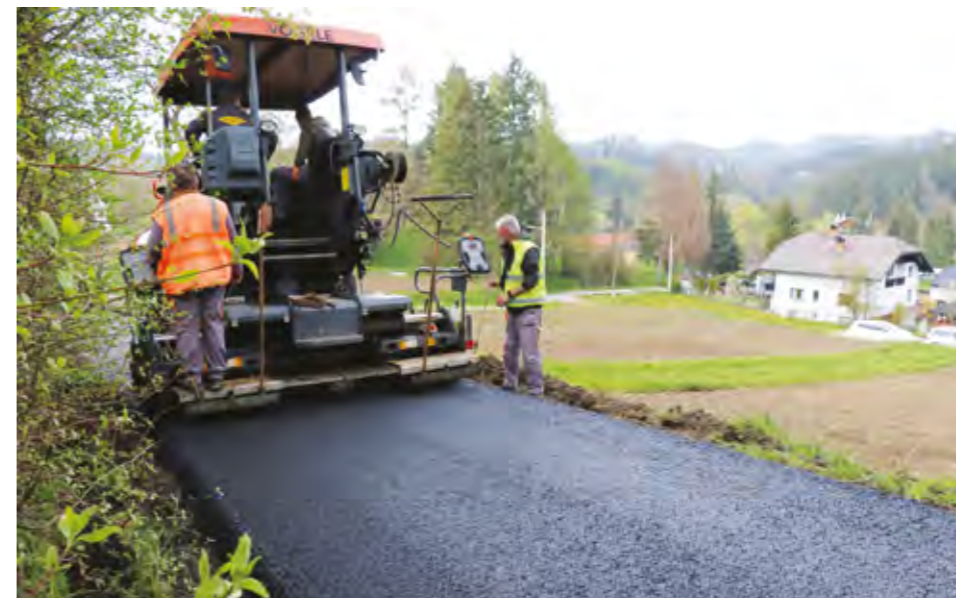
Sanacija prometnice u naselju Komesi
