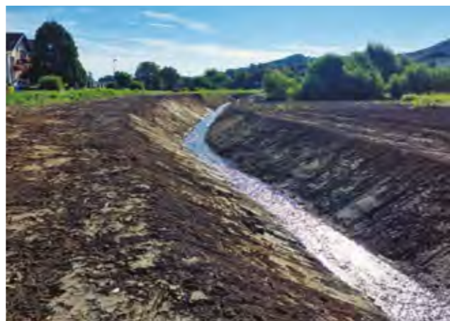
Hrvatske vode izvele su radove na uređenju potoka Kotnica
