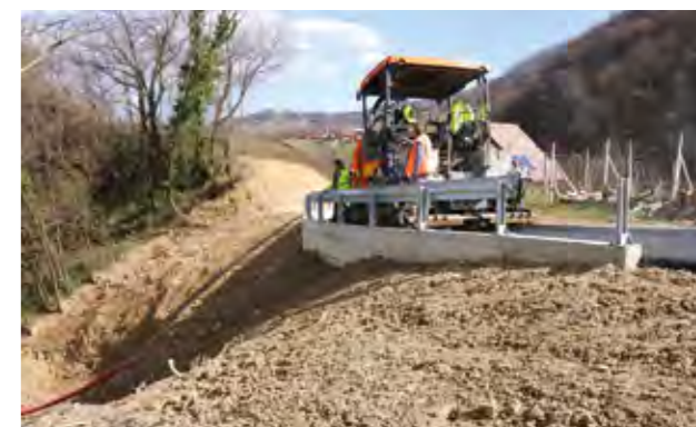
Sanacija klizišta na Gaveznicu
