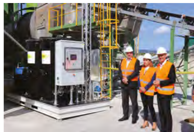
Ugradnja novog sustava u asfaltnoj bazi plod je suradnje tvrtke Colas s Gradom Lepoglavom
