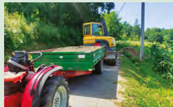
Radovi na uređenju oborinske odvodnje u Kameničkom Vrhovcu
