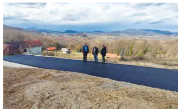
Obnovljeno je čak 11 prometnica
