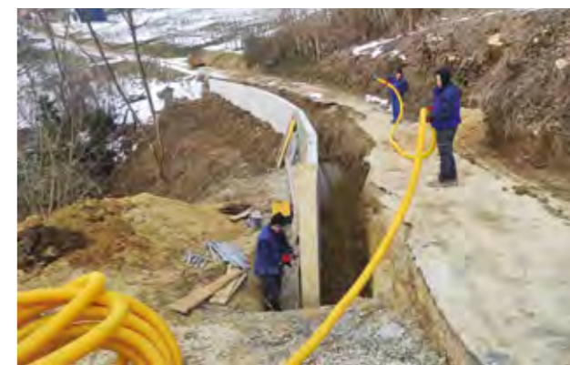
Opsežnim radovima spriječena je daljnja erozija tla
