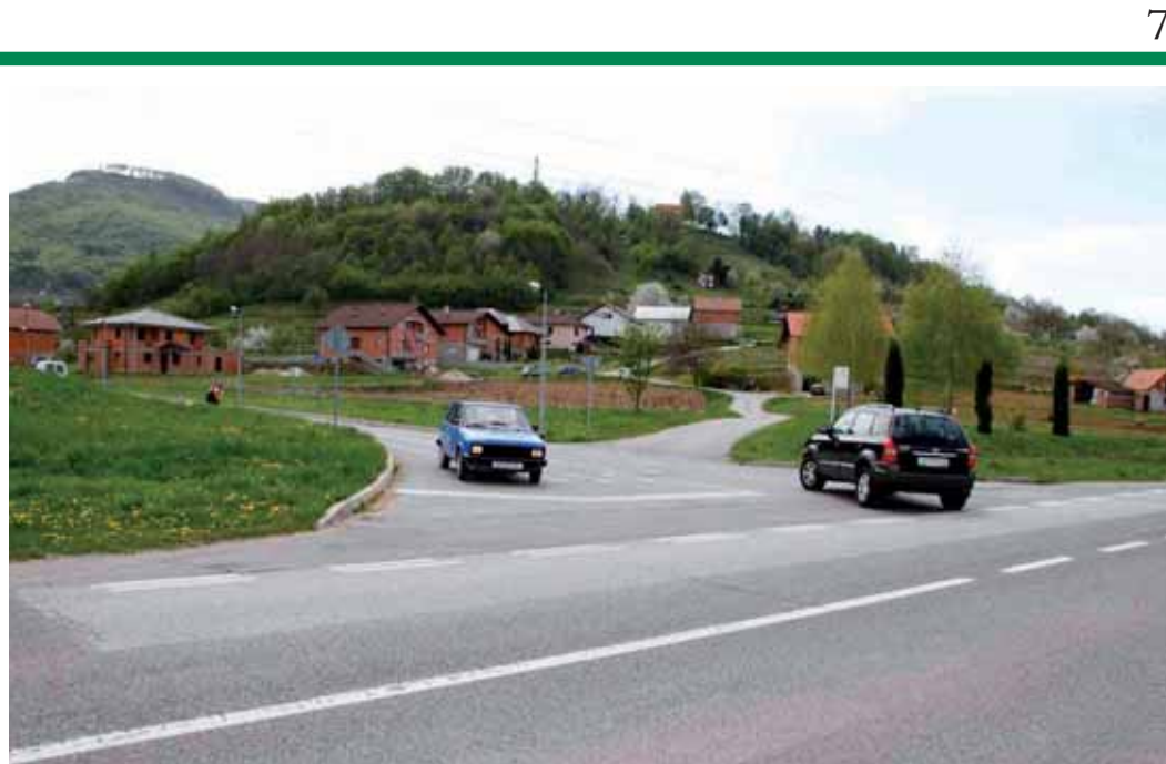
Kapitalni zabvati izvodit će se na obilaznici, gdje će se urediti raskrižje prema Stepinčevoj ulici
