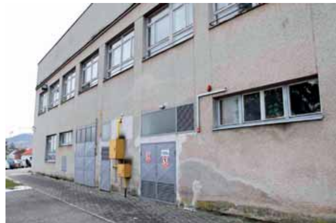
Obnovit će se i dotrajala fasada, a škola će dobiti i novi krov i stolariju
