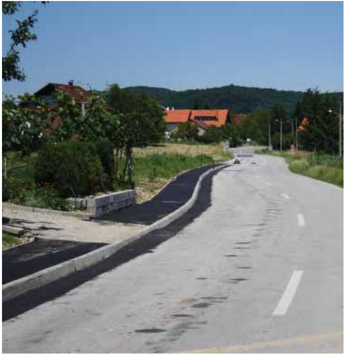
U Žarovnici je izgrađeno oko 450 m nogostupa što povećava sigurnost pješaka u prometu
