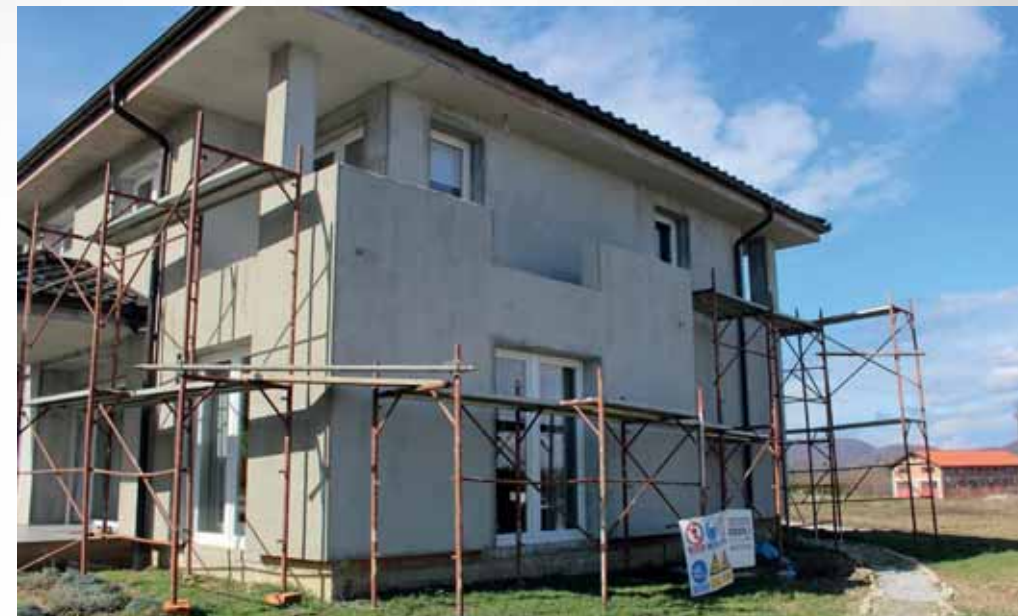
Obiteljska kuća obitelji Pavlek na kojoj se uređuje energetske učinkovite fasade
