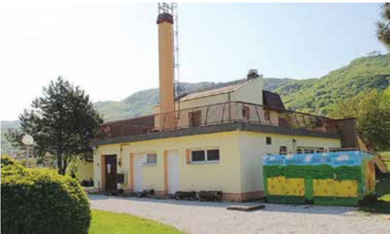
Jedan od prioriternih projekata u 2016. je dogradnja i rekonstrukcija zgrade dječjeg vrtića
