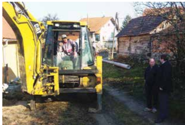
Stari drveni zamijenjeni su novim betonskim stupovima
